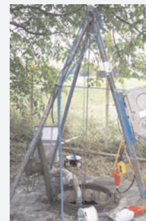
Pumpversuch mit Durchflussmessung
